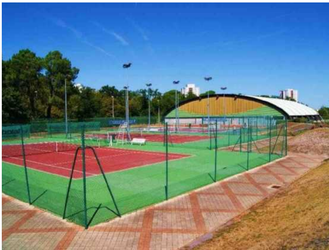
Deux courts de padel et un court de tennis couvert vont être construits. PHOTO US TALENCE TENNIS
